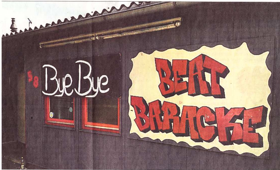
Völlig leer geräumt steht der Beat Baracke im Ramtel nach fast 40 Jahren als Jugendhaus der Abriss bevor.
