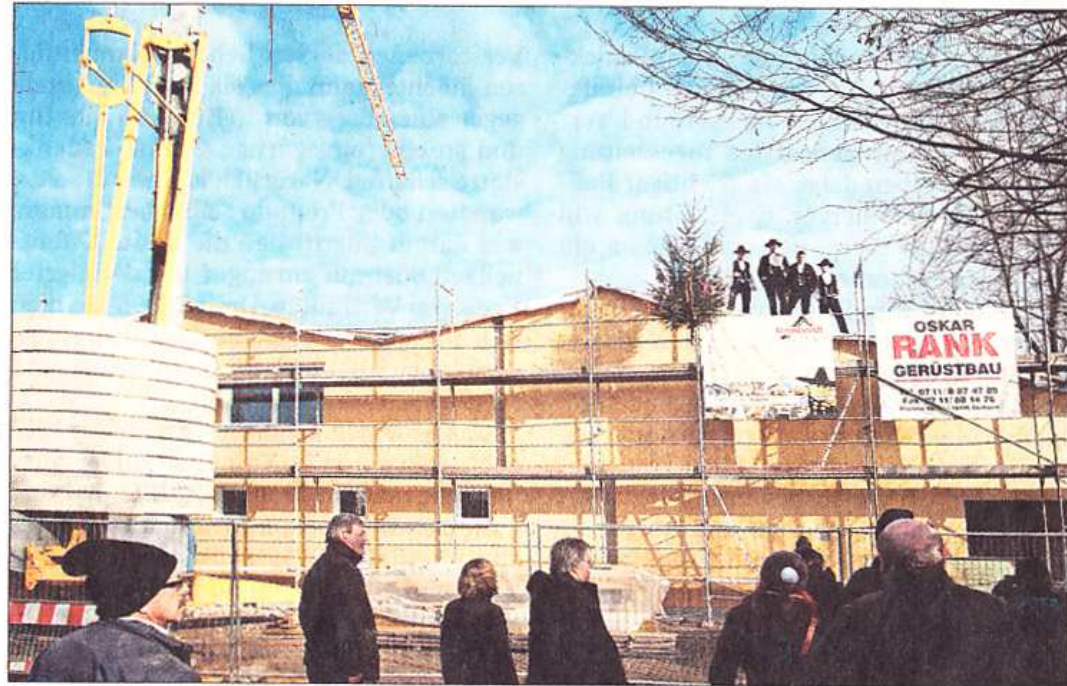
Der Rohbau des neuen Jugendhauses steht, das Richtfestbäumchen auch. Foto: factum/Granville
